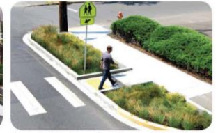
Portland, USA - Traversée piétonne - City of Portland
