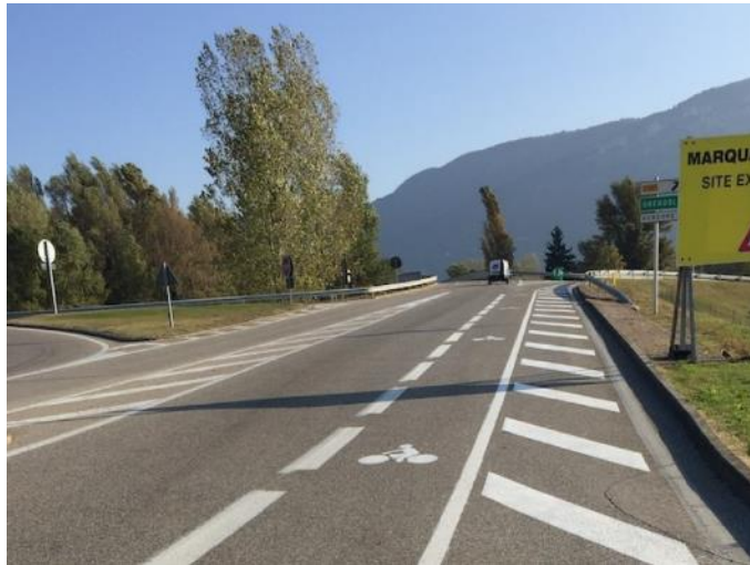
Chaussé à voie centrale banalisée Département de l'Isère
