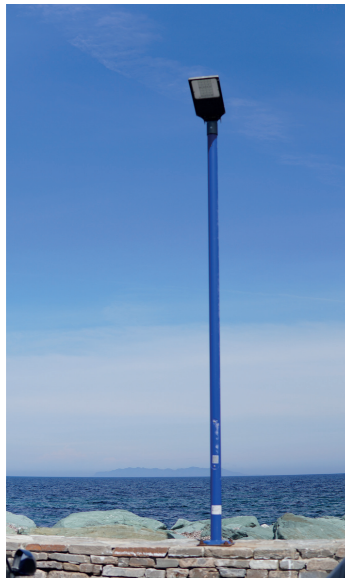
Luminaires du quai d'honneur, Macinaggio ©Convention d'étude ISCID, mai 2023
