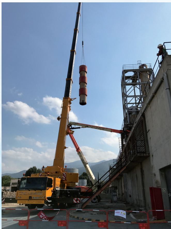
Démontage des cheminées de la centrale de Lucciana Juin 2017.
